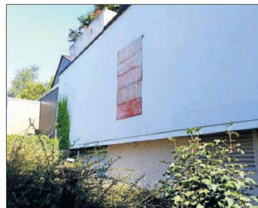
Über eine Treppe werden die künftigen Besucher vom Berliner Platz aus ins Innere gelangen, der Durchbruch existiert bereits.
