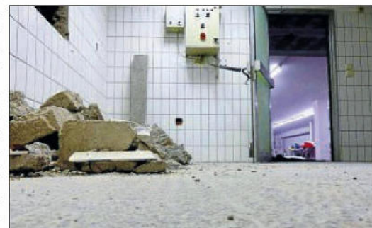
Überbleibsel eines Fensterdurchbruchs, der für Tageslicht in der neuen Küche sorgen wird
