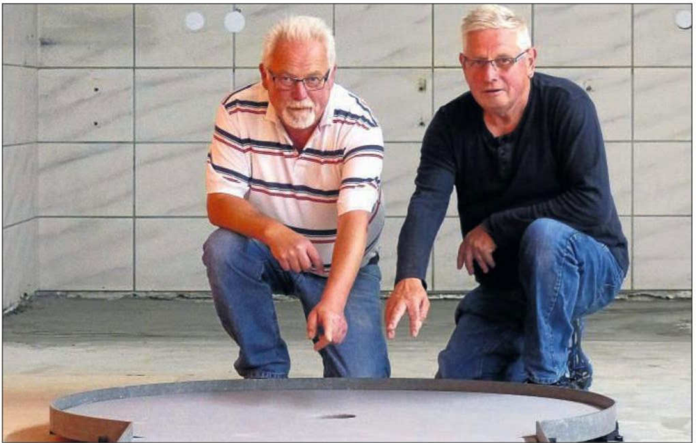
Klaus Zeisler (links, 1. Vorsitzender des SSC) und dessen Bruder Werner (Kassierer) arbeiten auf der Baustelle der Indoor-Minigolfanlage in der Halle. Die Betonfaser-Bahn haben sie getestet und für gut befunden: „Das Laufverhalten der Bälle ist ganz normal.“ ■ Fotos: Holz
